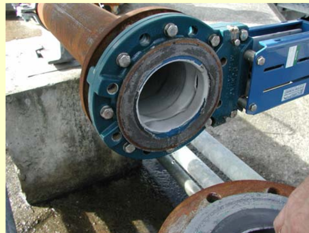
Bruchsal: Beschichtung Innenrohr
